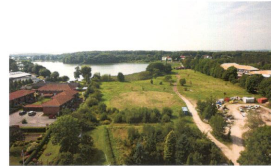
Udsigt mod syd fra Vestergade over det gamle gartneri, med Lillesø og Dyrehaven i baggrunden
